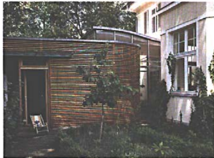
Ganz natürlich: Das Dach des Kinderhauses trägt aus Klimagründen eine Begrünung, die aber hinter den Sichtblenden verborgen bleibt.
